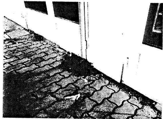
3. risanamento dei locali tecnologici (centrale termica e idrica) mediante opere di impermeabilizzazione e drenaggio, la cui assenza sono causa di evidenti infiltrazioni di acqua; sistemazione degli ingressi agli stessi, previa rimozione di instabili e pericolosi manufatti metallici;
